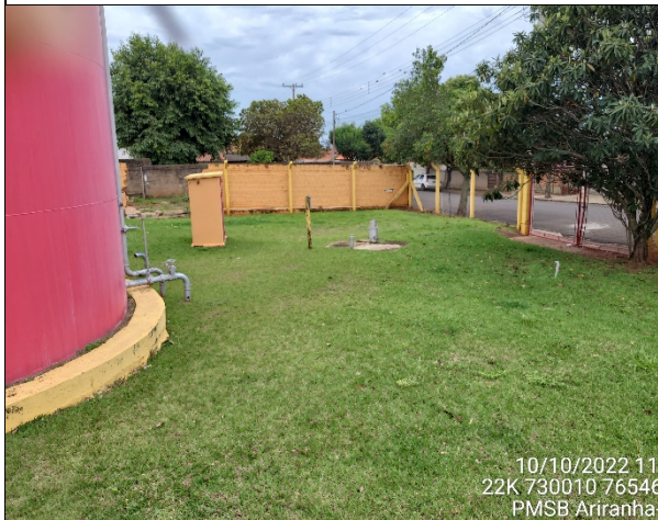
Foto 9 – Poço 04 – desativado. Localizado ao lado dos reservatórios “Taça” e “Auxiliar”
