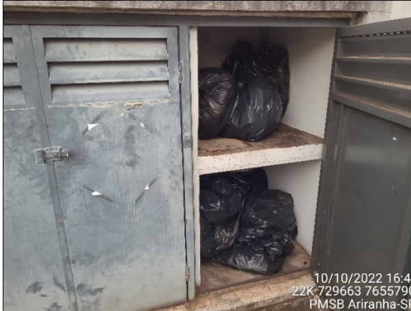
Foto 48 – Armazenamento temporário de RSS Classe D, em UBS, até a coleta por empresa terceirizada.
