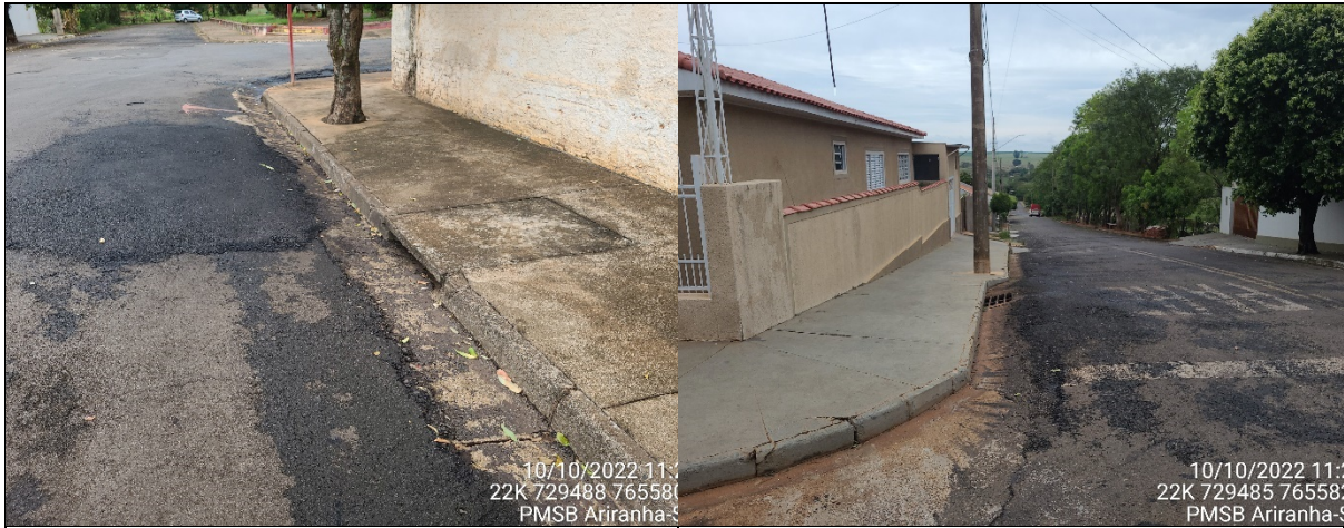
Foto 33 – Sistema de drenagem de água pluvial – detalhe para valeta e boca de lobo.
