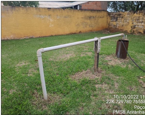
Foto 7 – Poço de captação número 7, localizado ao lado do reservatório central – Setor 1.
