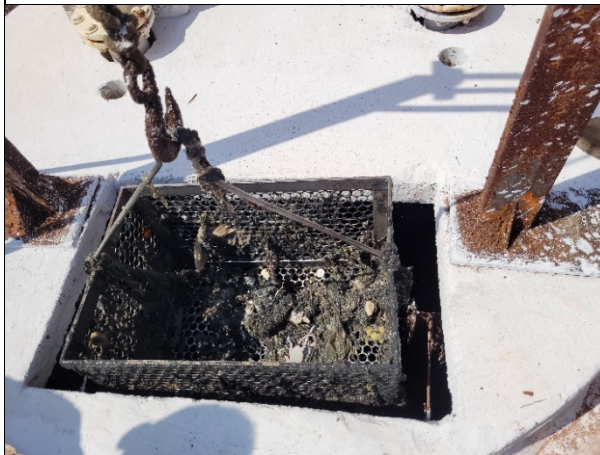
Foto 50 – Etapa de tratamento preliminar do sistema de esgotamento
