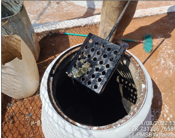
Foto 15 – Gradede limpeza manual para remoção de resíduos sólidos na Estação Elevatória.
