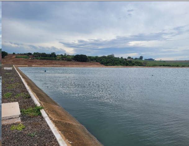
Foto 28 – ETE - Terceira lagoa: Lagoa de polimento. Destaque para a ausência de espuma.
