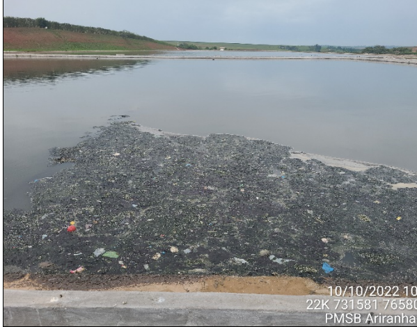
Foto 25 – ETE - Acúmulo de espuma com presença de resíduos sólidos grosseiros na primeira lagoa.
