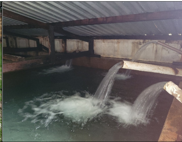
Foto 8 – Reservatório semi-enterrado central – Setor 1. Detalhe para o recebimento de água de 04 poços.
