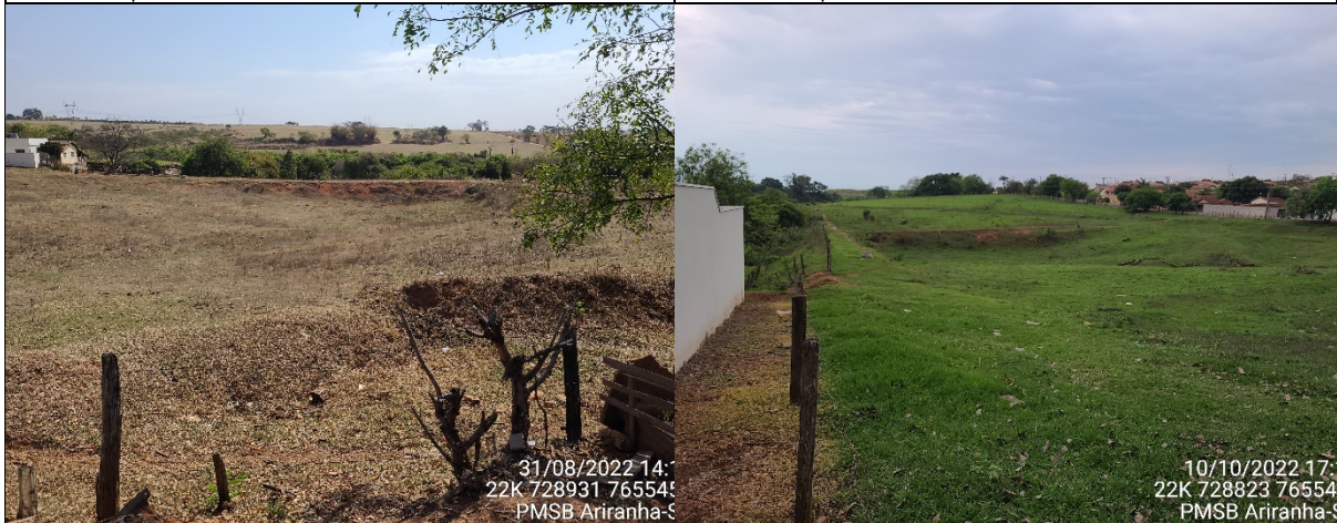
Foto 35 – Terreno na Rua Alcides de Oliveira entre as Ruas Siqueira Gomes e Barão do Rio Branco onde havia processo erosivo e problemas de alagamento.
