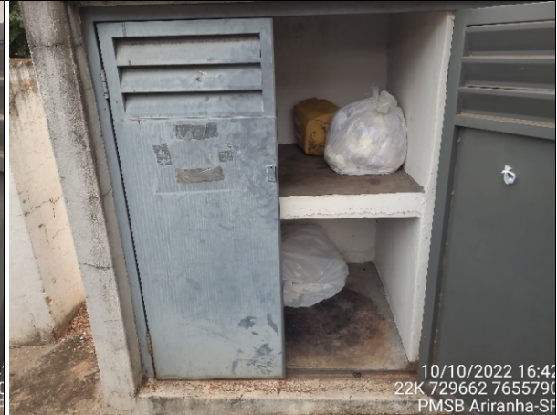
Foto 49 – Armazenamento temporário de RSS Classe A e E, em UBS, até a coleta por empresa terceirizada.
