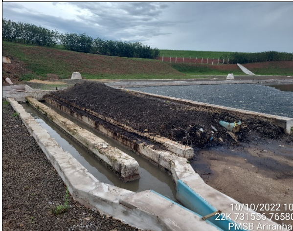
Foto 23 – ETE - Leito de secagem de lodo
