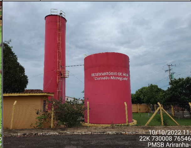
Foto 12 – Reservatório da “Taça” e “Auxiliar” – Setor 02.
