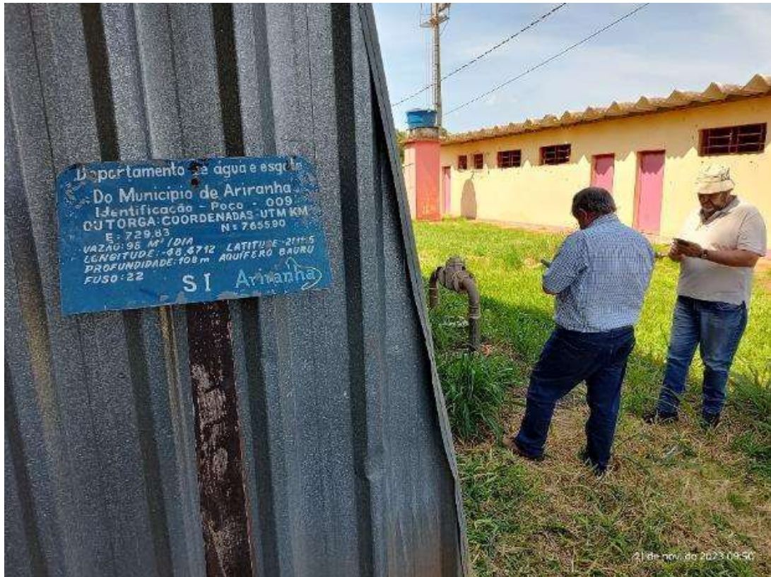
Foto 3 Vista do barrilete do Poço 9
