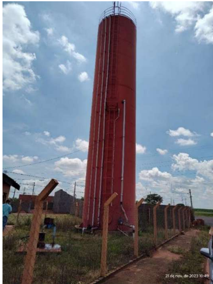
Foto 26 Vista do reservatório tipo torre do Sistema 6
