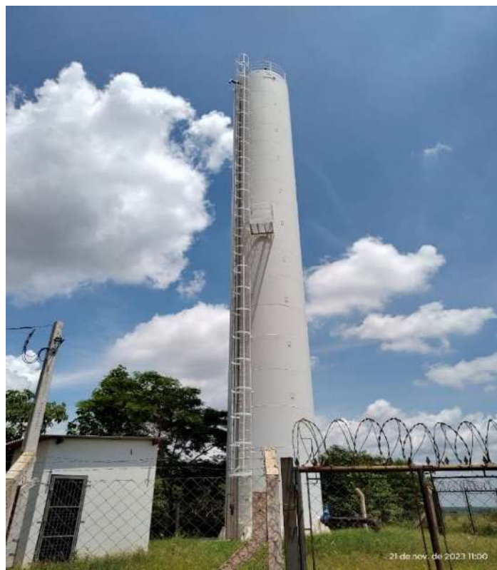
Foto 28 Vista do reservatório tipo torre
