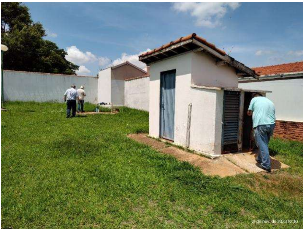
Foto 17 Sistema 3. Vista geral do poço 6. Em primeiro plano, nichos de abrigo do quadro elétrico e dos sistemas de armazenamento e dosagem de produtos químicos.
