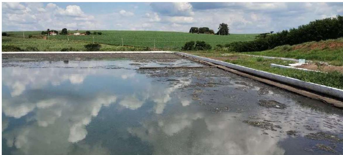
Foto 39 Vista parcial da lagoa anaeróbia
