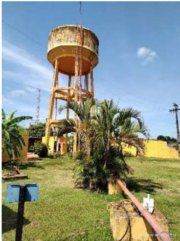
Foto 6 Vista do reservatório elevado
