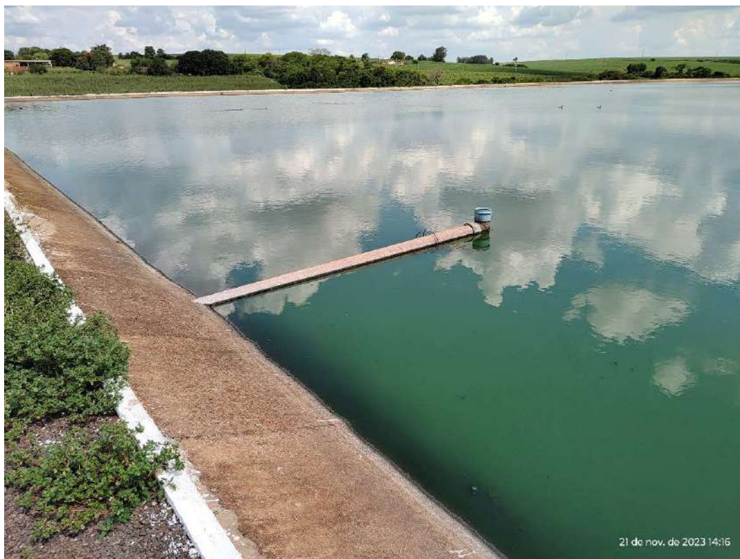
Foto 41 Vista parcial da lagoa de maturação
