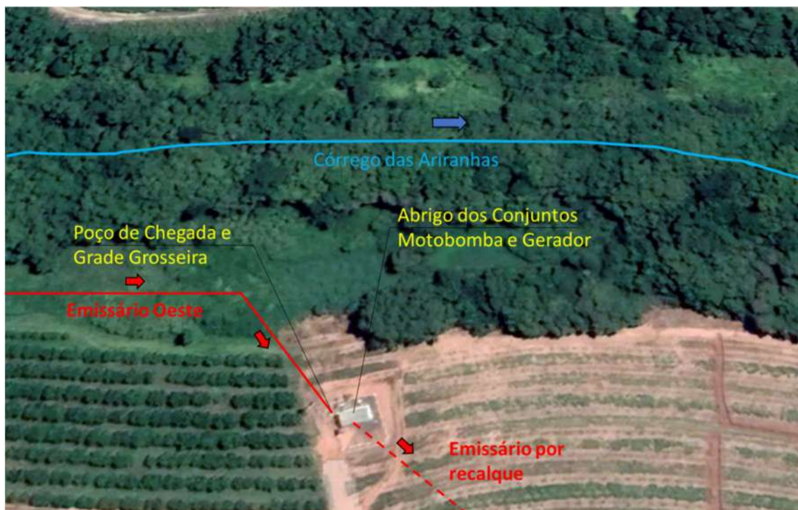
Figura 6.1 Imagem de satélite da estação elevatória de chegada do emissário oeste
