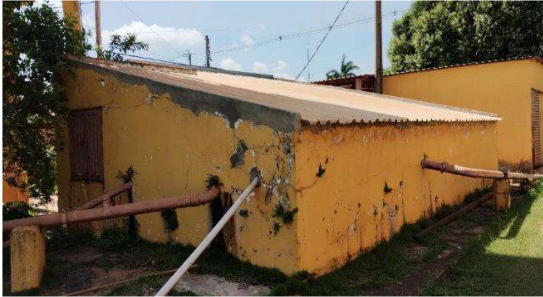
Foto 5 Vista do reservatório semienterrado
