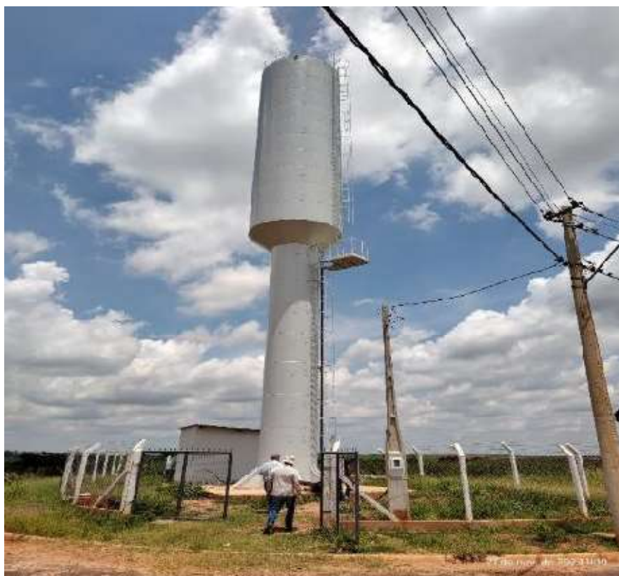
Foto 30 Vista geral do Sistema de Produção e Reservação 8
