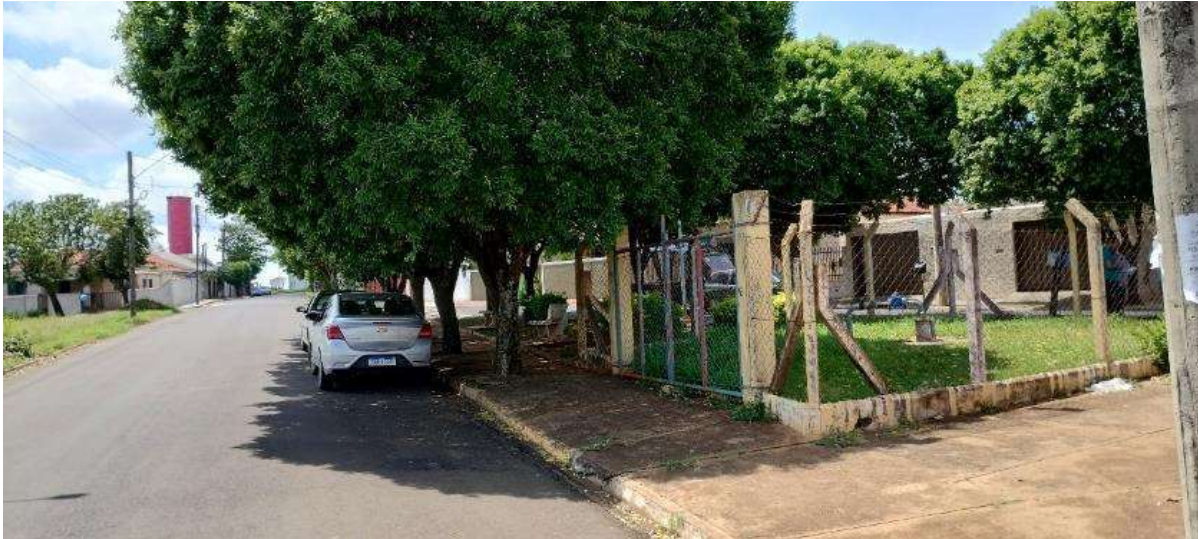
Foto 10 Vista geral das instalações do poço 11. Ao fundo, vista parcial do reservatório elevado do Centro de Reservação do Sistema 2 (CR2)
