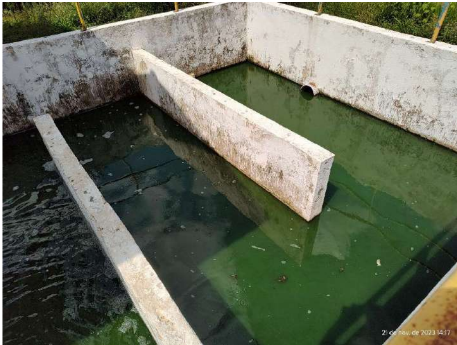
Foto 42 Vista parcial da câmara de contato
