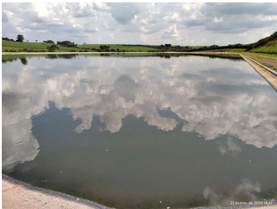
Foto 40 Vista parcial da lagoa facultativa
