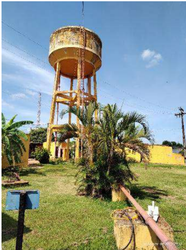
Foto 6 Vista do reservatório elevado
