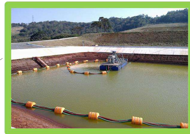
Sistema de Dragagem
