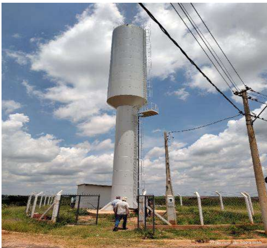
Foto 30 Vista geral do Sistema de Produção e Reservação 8
