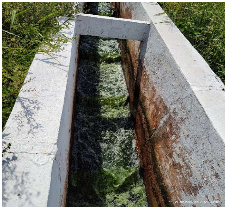
Foto 43 Vista parcial da escada hidráulica de arejamento do efluente
