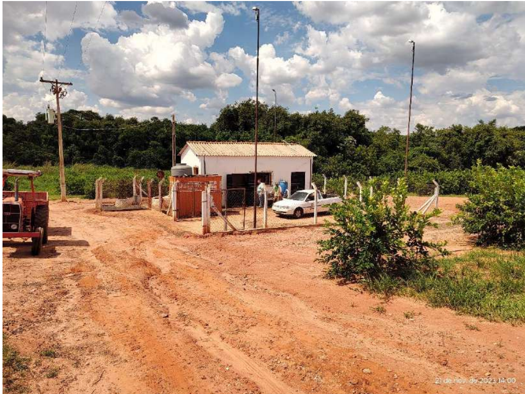
Foto 31 Vista geral da estação elevatória
