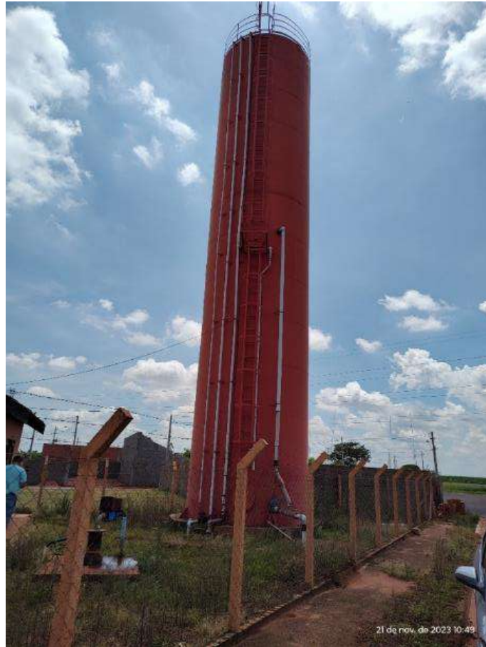
Foto 26 Vista do reservatório tipo torre do Sistema 6
