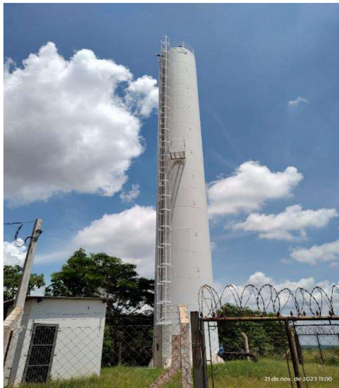
Foto 28 Vista do reservatório tipo torre
