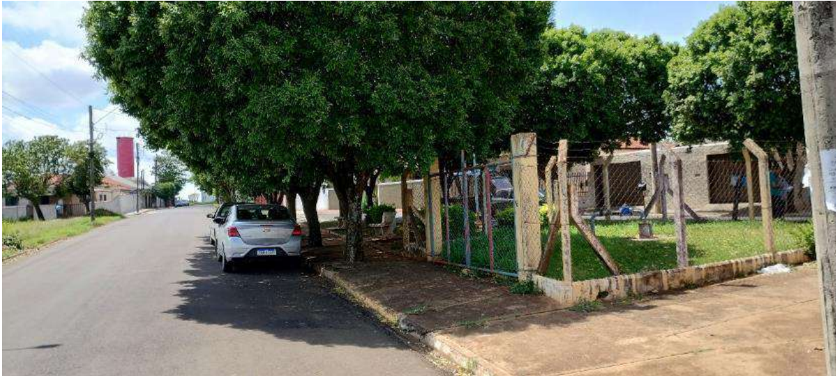
Foto 10 Vista geral das instalações do poço 11. Ao fundo, vista parcial do reservatório elevado do Centro de Reservação do Sistema 2 (CR2)
