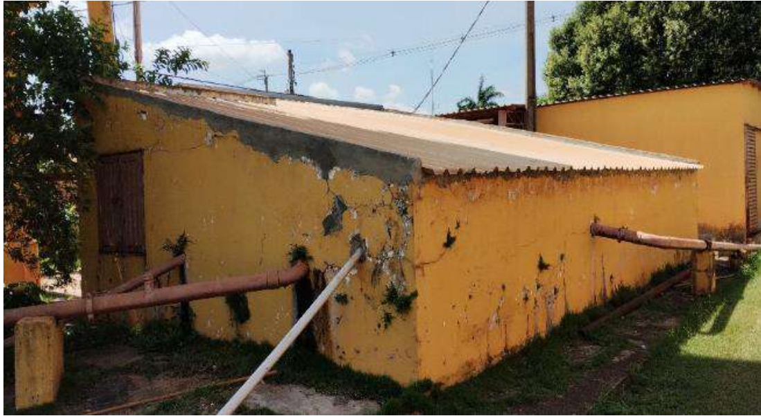
Foto 5 Vista do reservatório semienterrado
