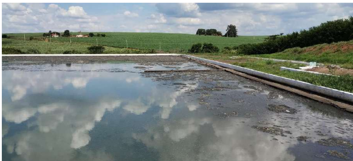
Foto 39 Vista parcial da lagoa anaeróbia
