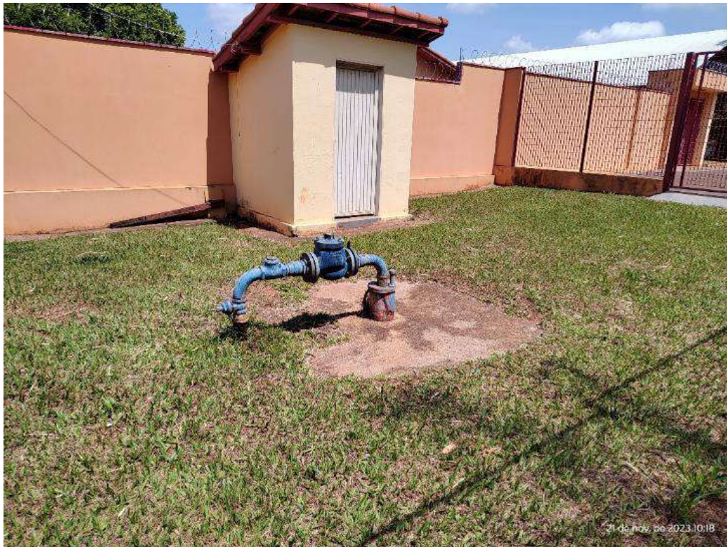
Foto 12 Vista geral e barrilete do poço 5
