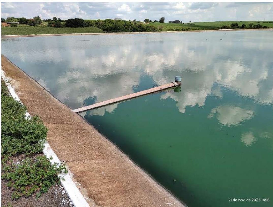
Foto 41 Vista parcial da lagoa de maturação
