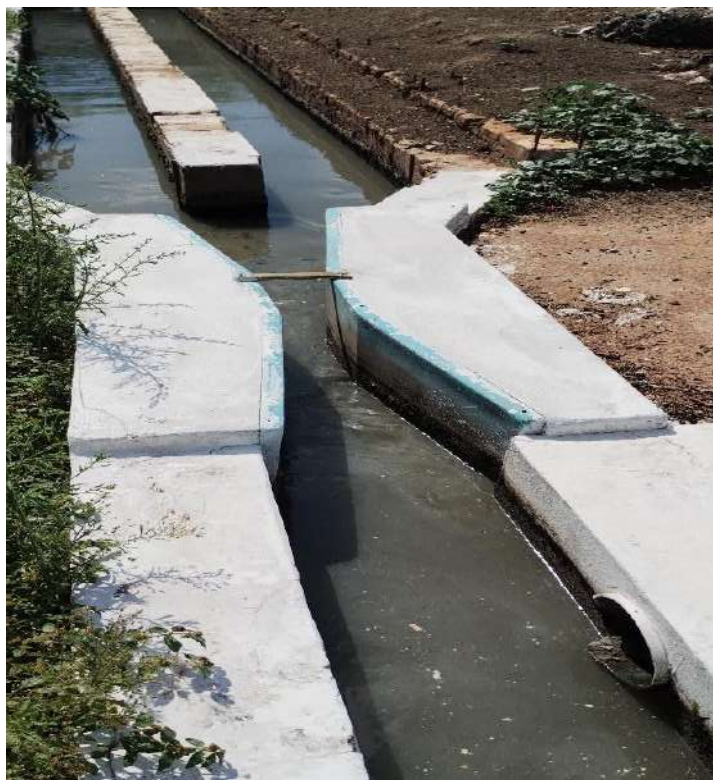
Foto 38 Vista a jusante dos canais de desarenação e calha Parshall
